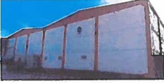
Katlı Hatların yer aldığı Konverting-2 Fabrikası
