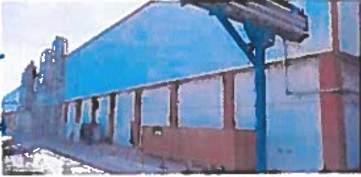
TM 1 ve TM 2 Binası
